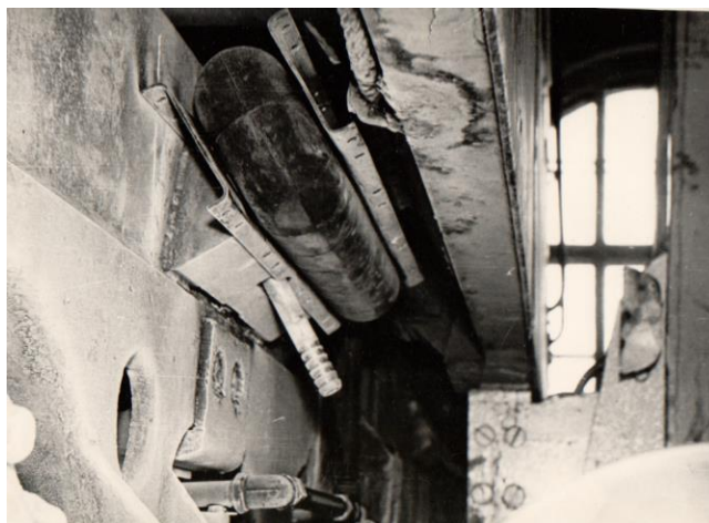
Рис.4. Установка пневмоэлемента между кузовом и тележками
